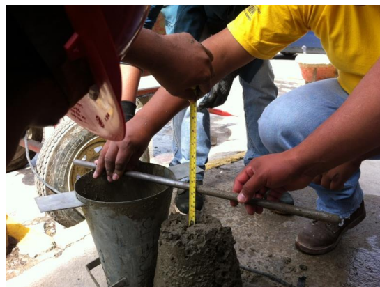
Figura 9. Medición del asentamiento del concreto
