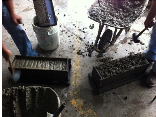
Figura 15. Llenado de la viga con mortero
