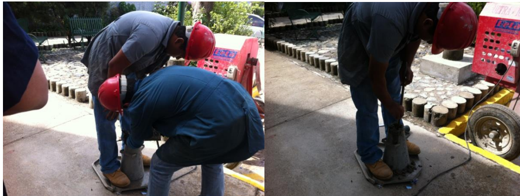
Figura 8. Llenado y apisonado en ensayo de asentamiento
