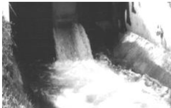
Figura 14. Turbulencia en el resalto hidráulico
