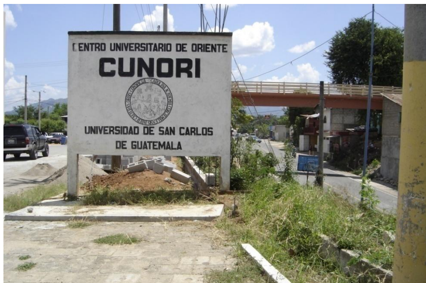
Figura 3. Instalaciones sin muro perimetral
