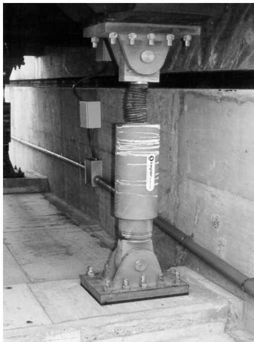
Figura 12. Disipador de energía
