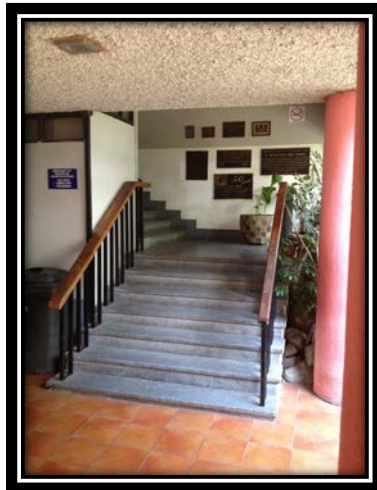
Figura 6. Ducto de gradas de ingreso del edificio T-5
