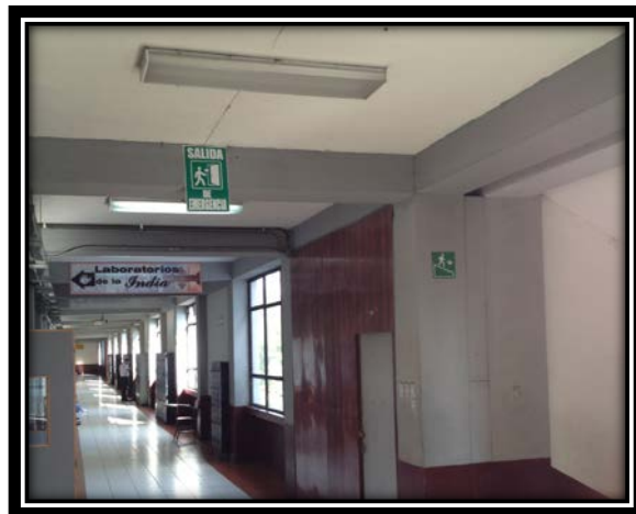
Fuente: cuarto nivel, edificio T-3
