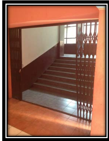
Figura 3. Ducto de gradas del edificio T-3
