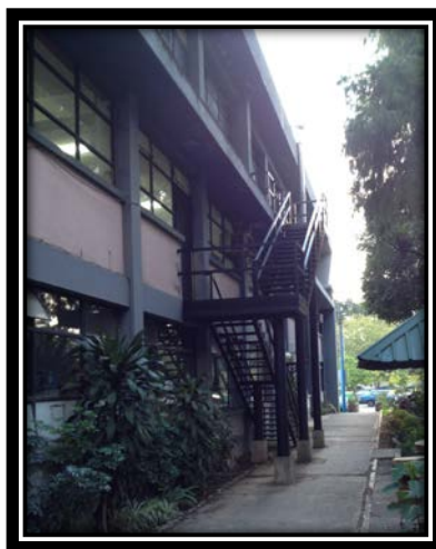
Figura 4. Ducto de gradas externo del edificio T-5
