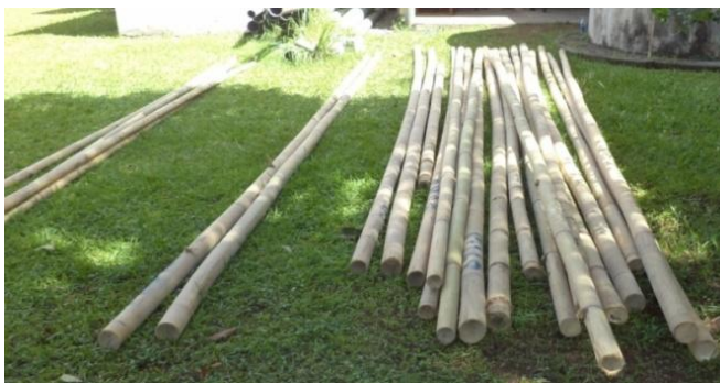
Figura 80. Materia prima para elaboración de vigas
