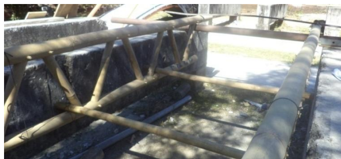
Figura 32. Arriostramiento de sistema de joist
