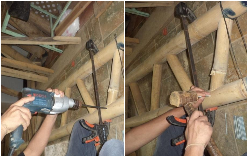
Figura 95. Perforación y colocación de pernos metálicos
