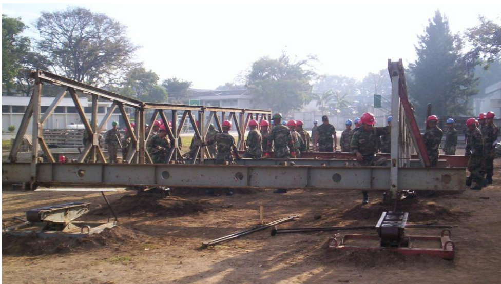
Figura 53. Nariz de lanzamiento de puente Bailey
