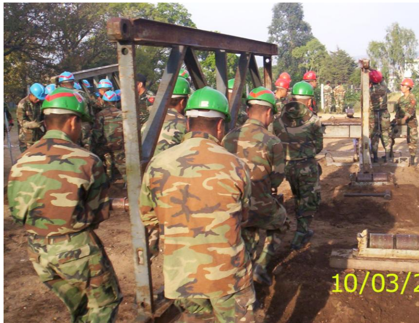
Figura 51. Grupo de paneles
