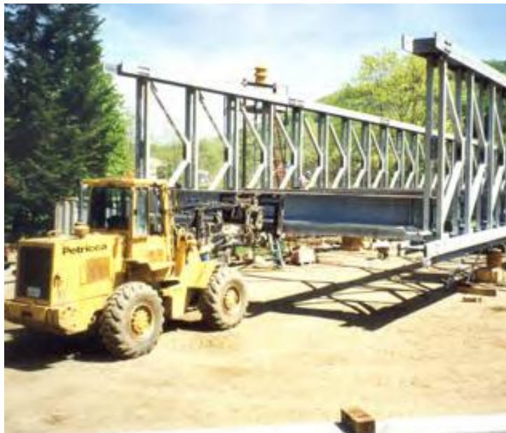
Figura 54. Lanzamiento de puente utilizando maquinaria
