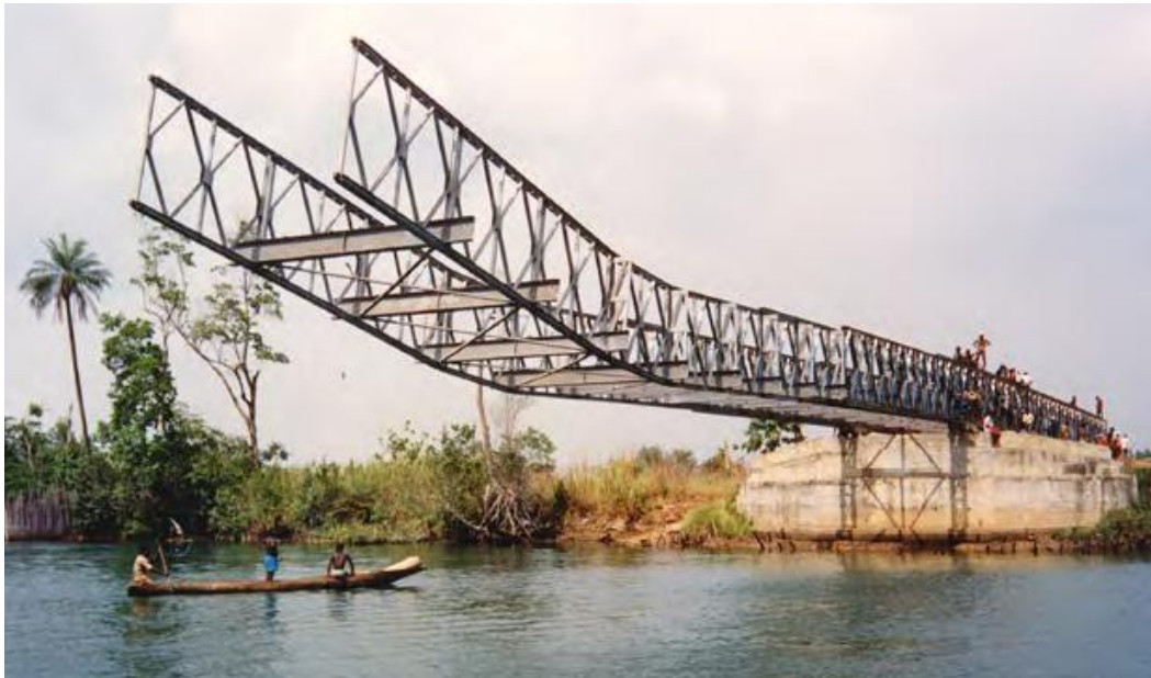
Figura 1. Lanzamiento de puente de emergencia
