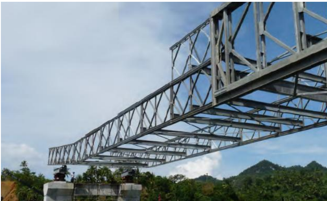
Figura 36. Lanzamiento de puente de emergencia tipo delta
