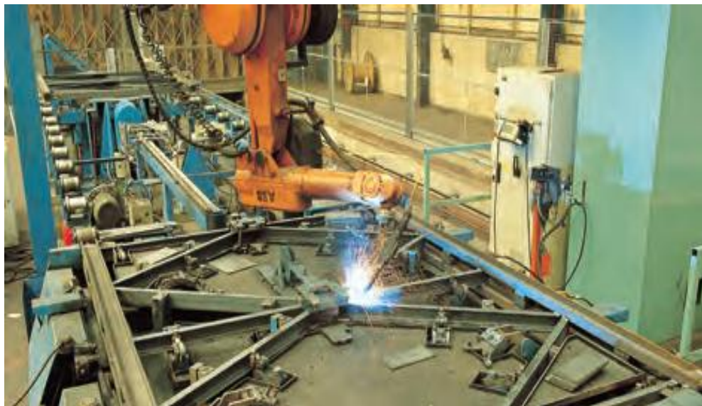
Figura 3. Fabricación de piezas de puentes
