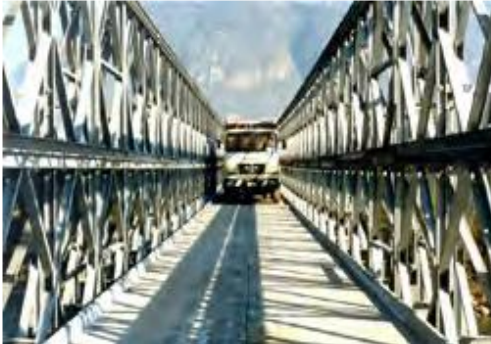
Figura 30. Ancho y altura de puentes
