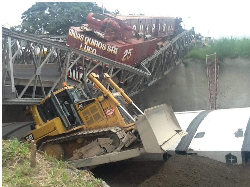
Figura 58. Puente Bailey colapsado por carga
