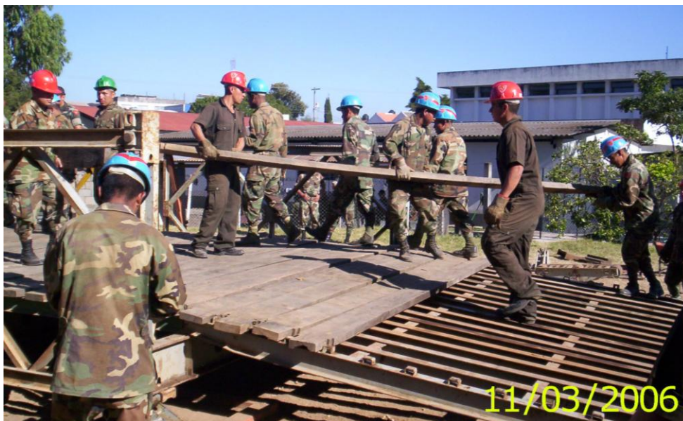
Figura 55. Grupo instalando rampa de acceso
