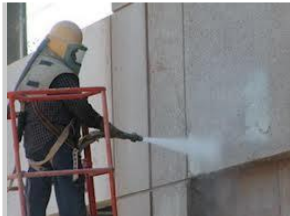
Figura 60. Limpieza mediante sand blast
