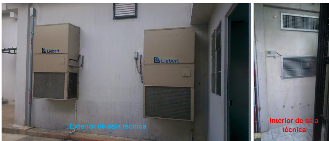
Figura 44. Aire acondicionado tipo mochila
