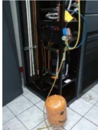
Figura 41. Carga de sistema de refrigeración
