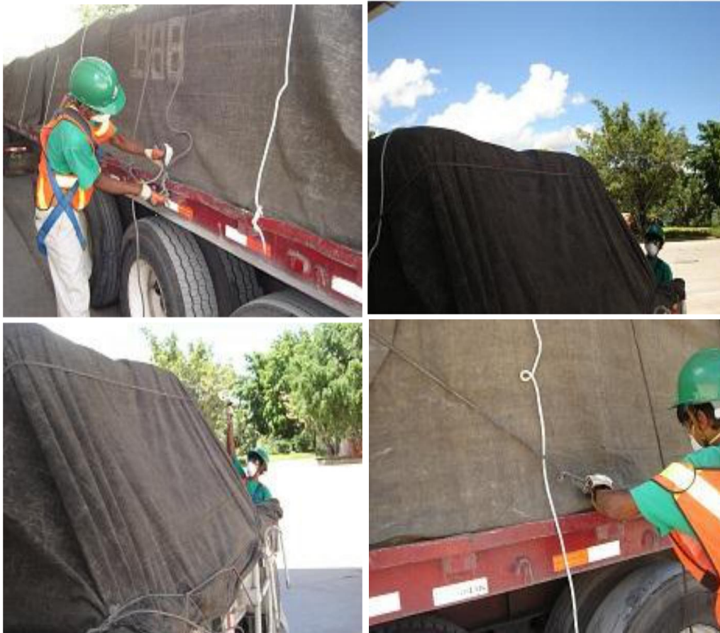
Figura 30. Fotografías del paso número 15 para el proceso de enlonado
