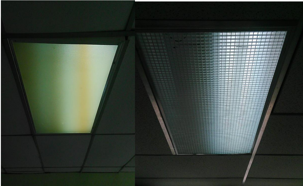
Figura 124. Luminarias funcionando al 50 % de su capacidad (únicamente con dos de los cuatro tubos)
