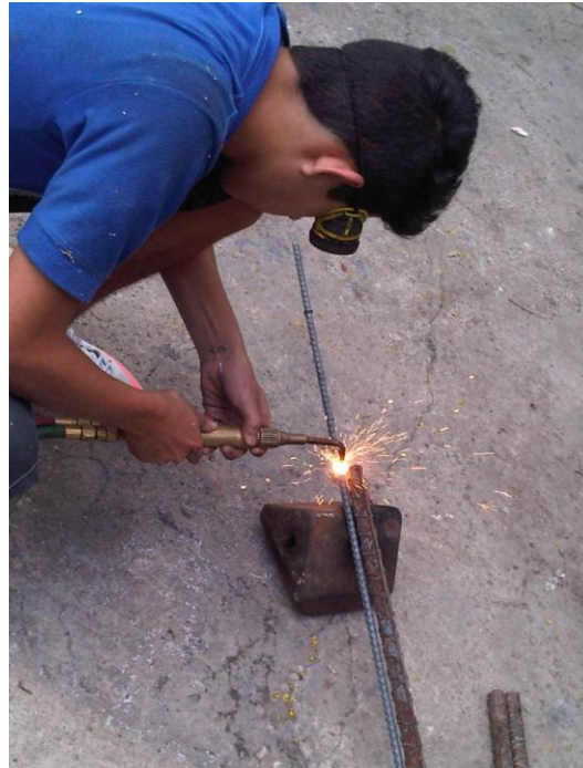
Figura 22. Procedimiento de corte de barras de acero con acetileno
