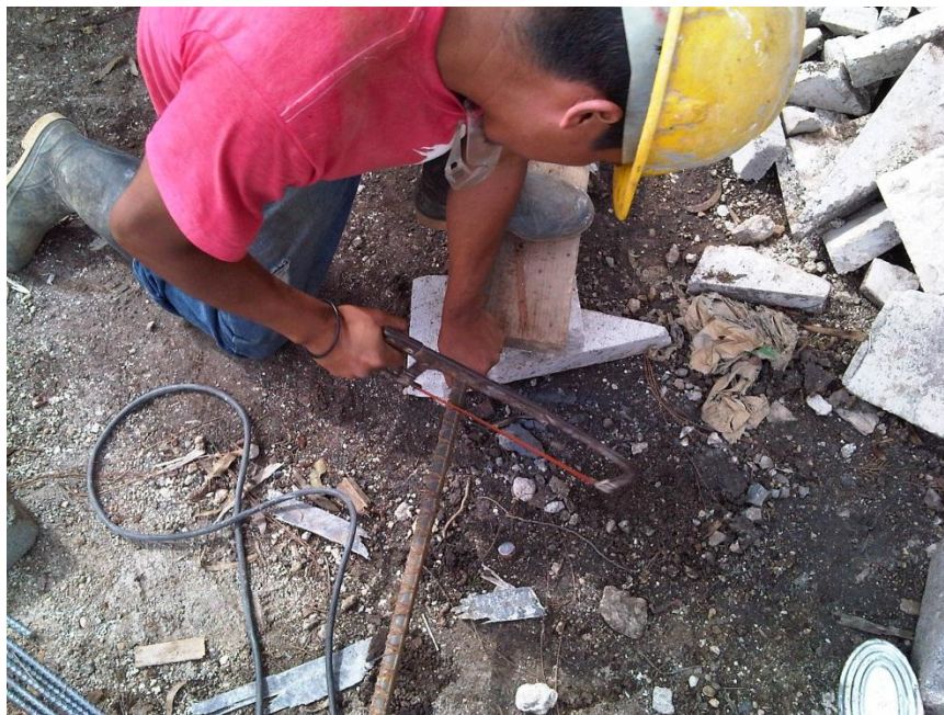
Figura 20. Procedimiento de corte de barras de acero con sierra de arco
