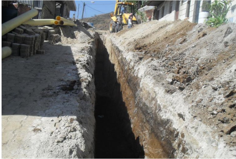
Figura 7. Excavación de zanja para agua potable
