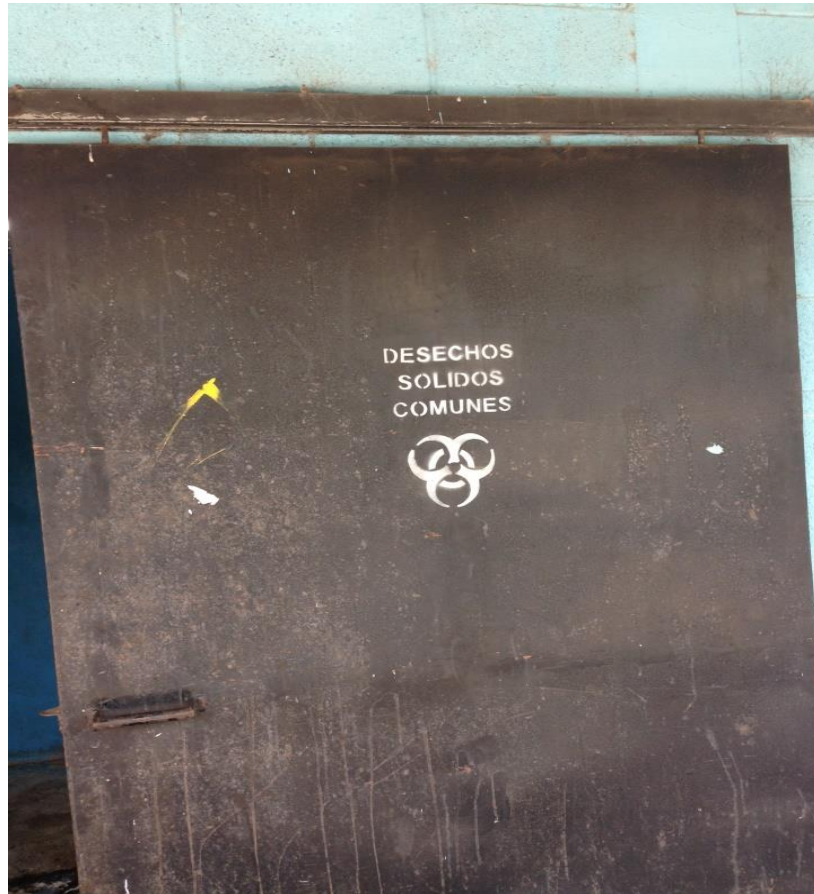
Figura 10. Instalaciones para el almacenamiento temporal de desechos sólidos comunes
