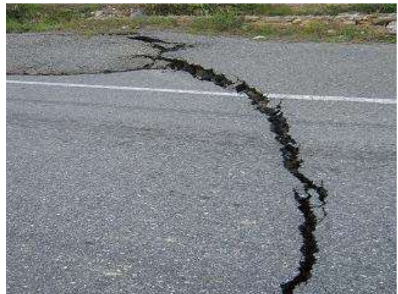
Figura 18: Levantamiento de losas. Jornada de actualización técnica “Diseño y Construcción de pavimentos de Hormigón” Ing. Diego H. Calo, 20 de noviembre de 2008.
