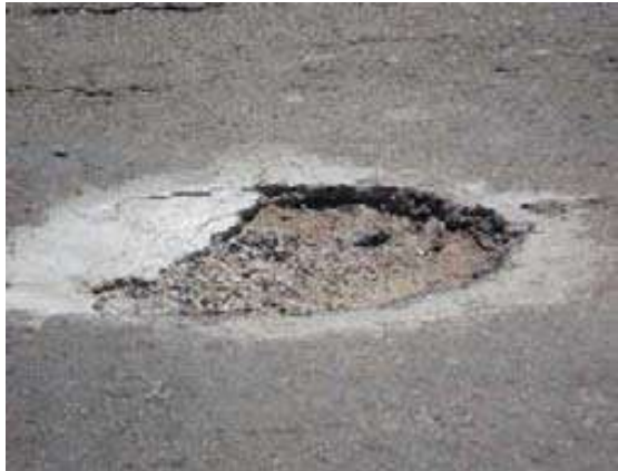
Figura 33: Baches Jornada de actualización técnica "Diseño y Construcción de pavimentos de Hormigón" Ing. Diego H. Calo, 20 de noviembre de 2008.
