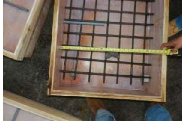
Figura 36: Verificación del diseño de las formaletas puestas en el sitio del proyecto en construcción del tramo carretera Cañas-Liberia.
