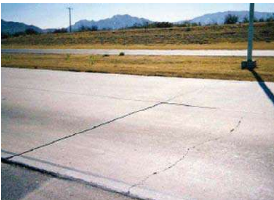
Figura 13: Fisura transversal. Jornada de actualización técnica “Diseño y Construcción de pavimentos de Hormigón” Ing. Diego H. Calo, 20 de noviembre de 2008.
