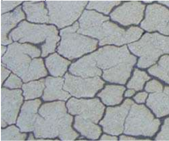
Figura 23: Reacción álcali agregado. Jornada de actualización técnica "Diseño y Construcción de pavimentos de Hormigón" Ing. Diego H. Calo, 20 de noviembre de 2008.
