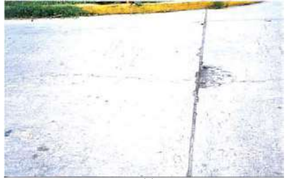
Figura 20: Desportillamiento de junta. Jornada de actualización técnica "Diseño y Construcción de pavimentos de Hormigón" Ing. Diego H. Calo, 20 de noviembre de 2008.
