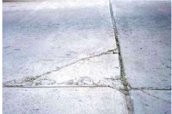
Figura 14: Rotura de esquina. Jornada de actualización técnica “Diseño y Construcción de pavimentos de Hormigón” Ing. Diego H. Calo, 20 de noviembre de 2008.
