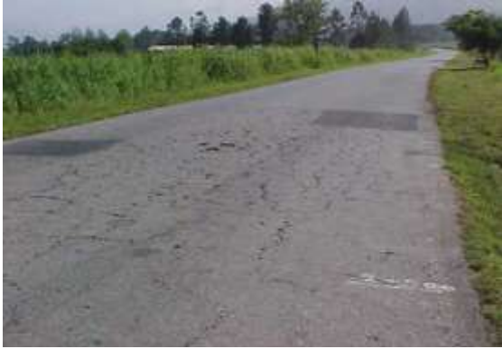
Figura 28: Fisuras inducidas. Jornada de actualización técnica “Diseño y Construcción de pavimentos de Hormigón” Ing. Diego H. Calo, 20 de noviembre de 2008.
