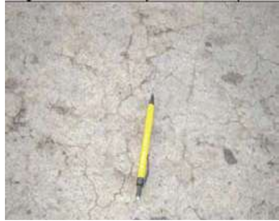
Figura 24: Fisuras tipo malla. Jornada de actualización técnica "Diseño y Construcción de pavimentos de Hormigón" Ing. Diego H. Calo, 20 de noviembre de 2008.
