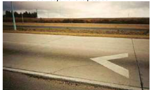
Figura 15: Rotura de esquina. Jornada de actualización técnica “Diseño y Construcción de pavimentos de Hormigón” Ing. Diego H. Calo, 20 de noviembre de 2008.
