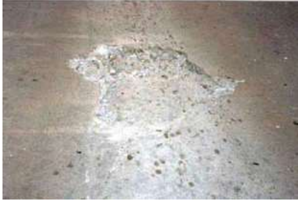
Figura 32: Baches. Jornada de actualización técnica "Diseño y Construcción de pavimentos de Hormigón" Ing. Diego H. Calo, 20 de noviembre de 2008.
