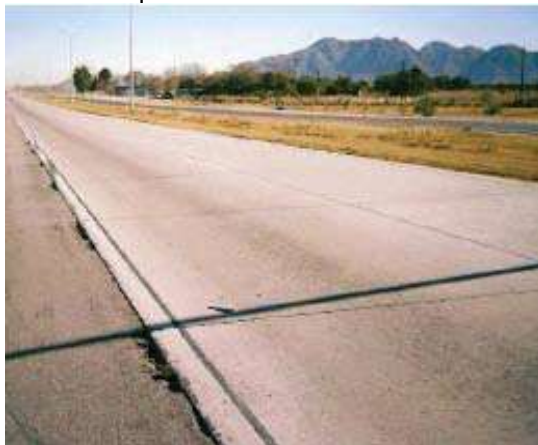
Figura 16: Erosión por bombeo. Jornada de actualización técnica “Diseño y Construcción de pavimentos de Hormigón” Ing. Diego H. Calo, 20 de noviembre de 2008.
