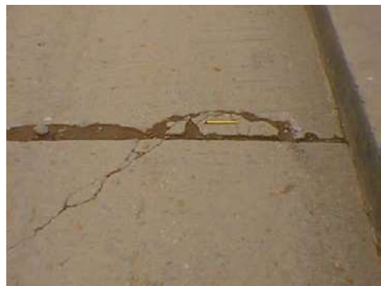
Figura 21: Desportillamiento de junta. Jornada de actualización técnica "Diseño y Construcción de pavimentos de Hormigón" Ing. Diego H. Calo, 20 de noviembre de 2008.
