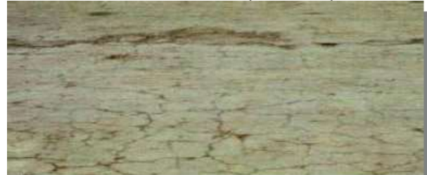
Figura 27: Fisuras en bloque. Jornada de actualización técnica "Diseño y Construcción de pavimentos de Hormigón" Ing. Diego H. Calo, 20 de noviembre de 2008.
