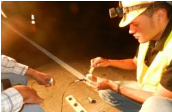
Figura 48: Aplicación de acoplante a los transductores.
