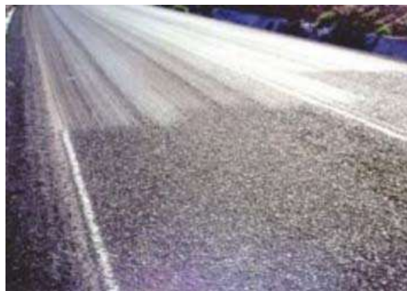
Figura 31: Agregado expuesto. Jornada de actualización técnica “Diseño y Construcción de pavimentos de Hormigón” Ing. Diego H. Calo, 20 de noviembre de 2008.
