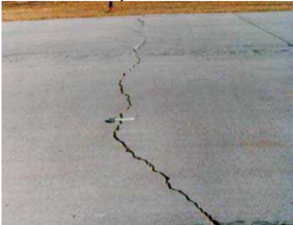
Figura 12: Fisura transversal. Jornada de actualización técnica “Diseño y Construcción de pavimentos de Hormigón” Ing. Diego H. Calo, 20 de noviembre de 2008.
