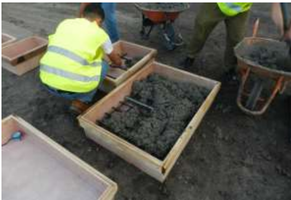
Figura 38: Proceso de fundido de los patrones manteniendo las características de diseño.
