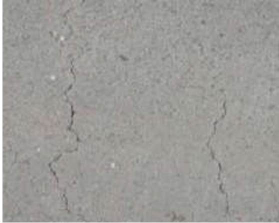
Figura 25: Fisuras tipo malla. Jornada de actualización técnica "Diseño y Construcción de pavimentos de Hormigón" Ing. Diego H. Calo, 20 de noviembre de 2008.
