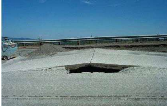
Figura 19: Levantamiento de losas. Jornada de actualización técnica "Diseño y Construcción de pavimentos de Hormigón" Ing. Diego H. Calo, 20 de noviembre de 2008.
