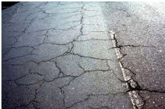
Figura 26: Fisuras en bloque. Jornada de actualización técnica "Diseño y Construcción de pavimentos de Hormigón" Ing. Diego H. Calo, 20 de noviembre de 2008.
