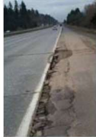
Figura 17: Erosión por bombeo. Jornada de actualización técnica “Diseño y Construcción de pavimentos de Hormigón” Ing. Diego H. Calo, 20 de noviembre de 2008.
