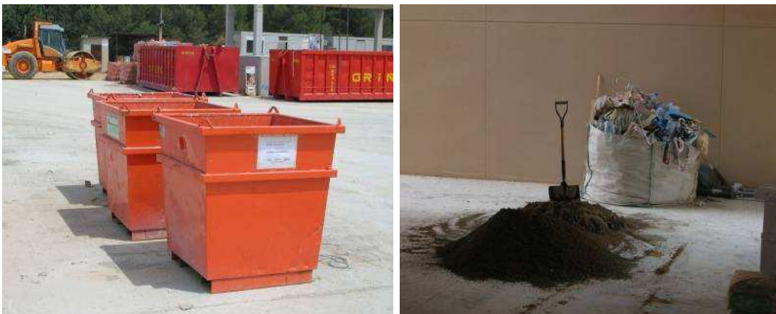
Figura 5. Manejo de residuos de construcción en obra
