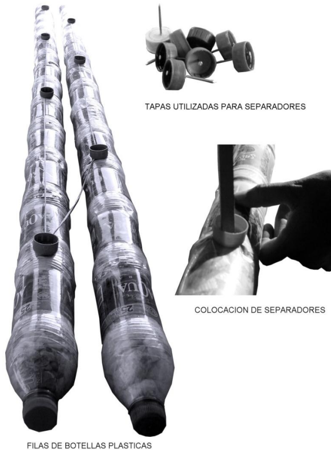
Figura 10. Separadores intermedios
