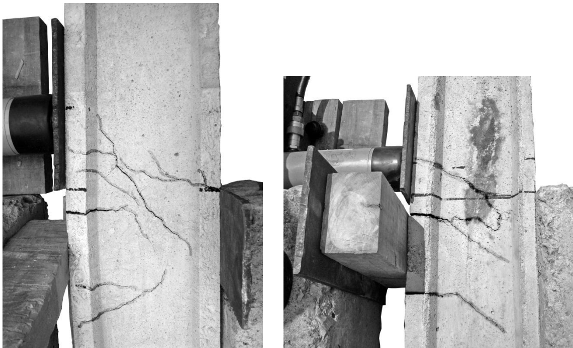
Figura 24. Fallas en columnas a corte
