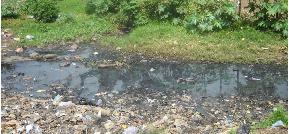
Figura 7. Fotografía del desagüe identificado en el casco urbano
