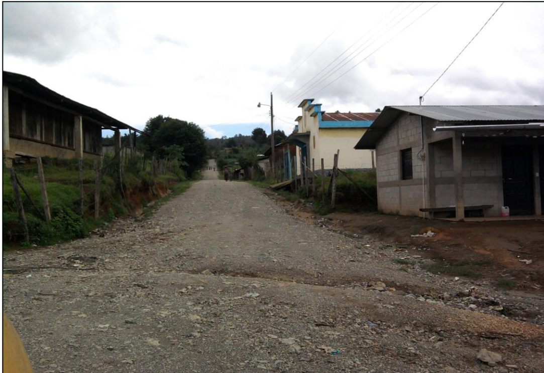
Figura 3. Camino rural QUI-42, ruta CA-10 occidente, Rincón de los Leones
