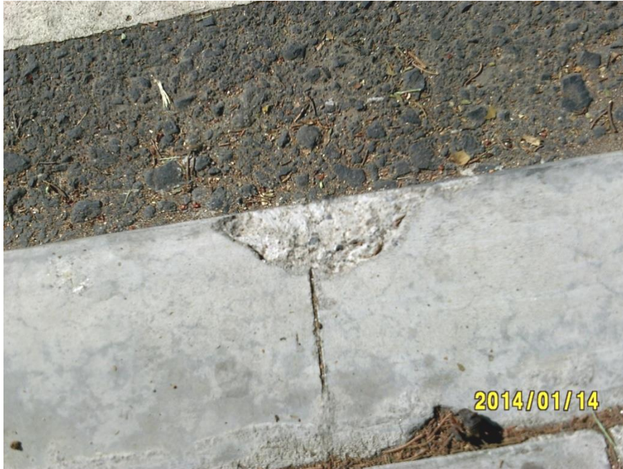
Figura 7. Junta de dilatación
