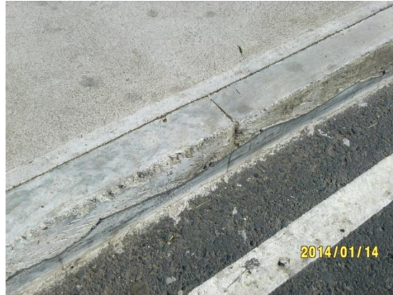
Figura 4. Desgaste por abrasión
