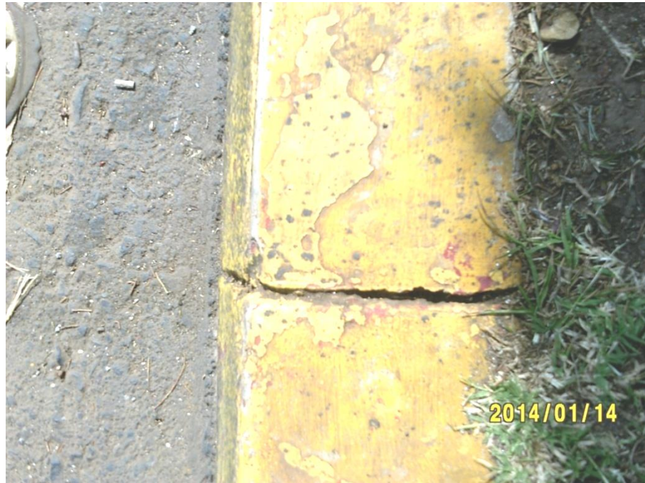
Figura 8. Bordillos ya existentes
