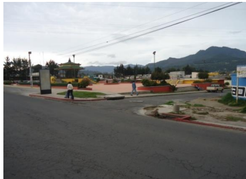
Figura 17. La falta de señalización preventiva en la 25 avenida
