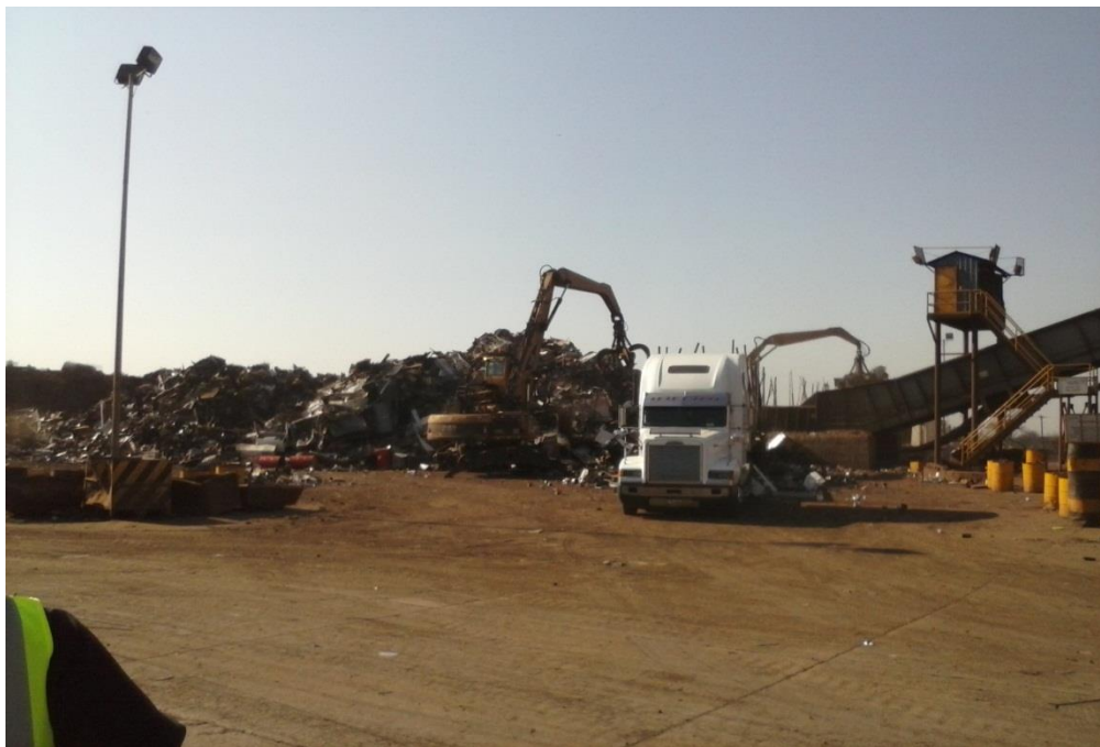
Figura 5. Área de carga y descarga de chatarra, planta SIDEGUA
