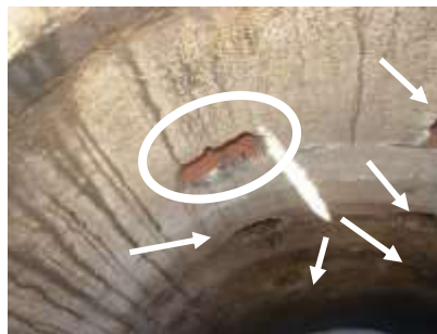
Figura 3. Interior pozo correspondiente a zona 4
