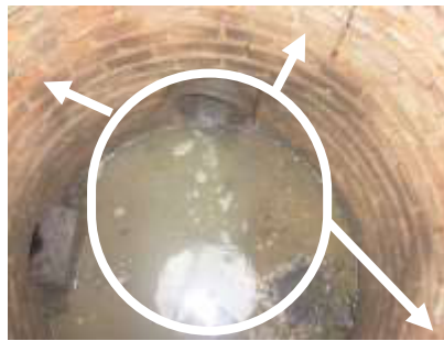
Figura 8. Interior pozo correspondiente a zona 5
