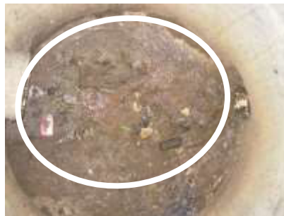
Figura 2. Interior pozo correspondiente a zona 1
