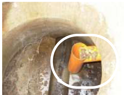
Figura 5. Interior pozo correspondiente a zona 2
