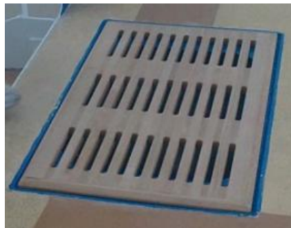
Figura 28. Trampa de desechos sólidos
