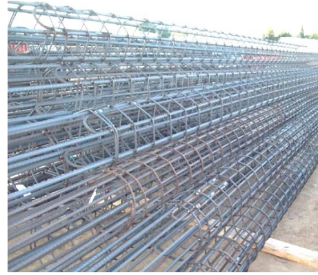
Armadura de las pilas que se fundirán
