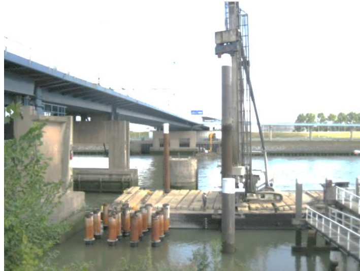
Figura 64. Instalación de pilotes de acero en un medio saturado
