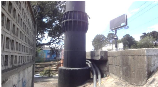
Figura 7. Empalme tipo de una columna de un rótulo
