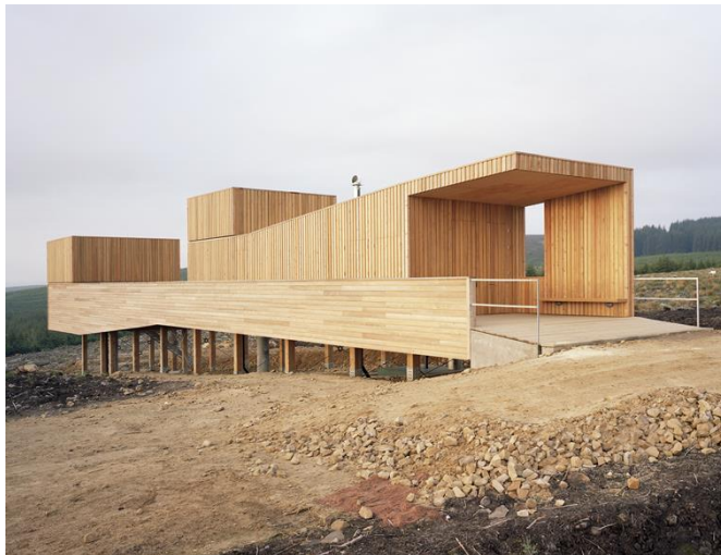
Figura 67. Superestructura soportada por pilotes de madera
