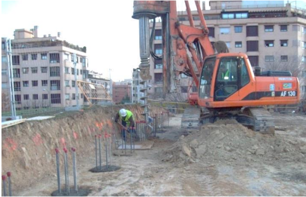
Perforación de los pozos donde se fundirá la pila
