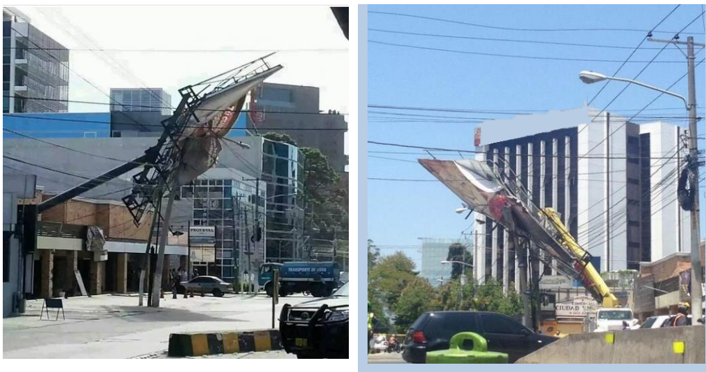
Figura 9. Rótulo fallado en la ciudad de Guatemala
