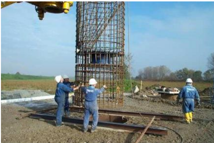
Figura 65. Refuerzo de un pilote de concreto colado in situ
