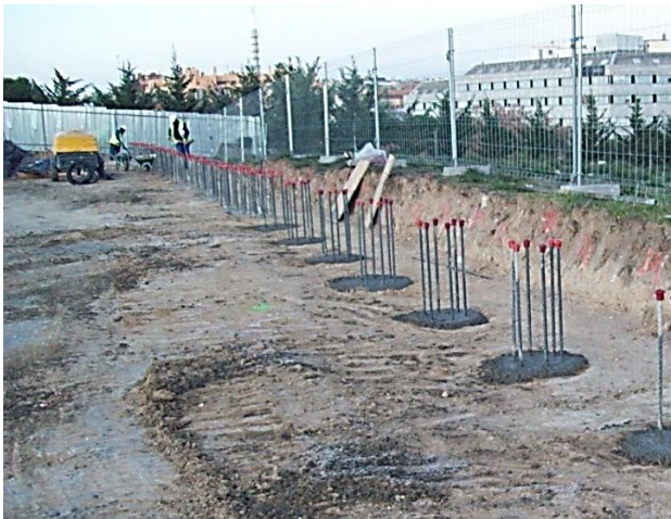
Pilas fundidas y en proceso de fraguado
