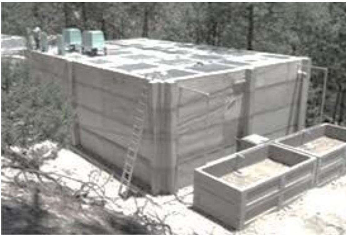
Figura 4. Planta de tratamiento construida en sitio
