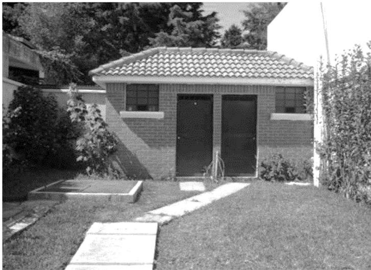
Figura 11. Caseta control de mando de bombeo
