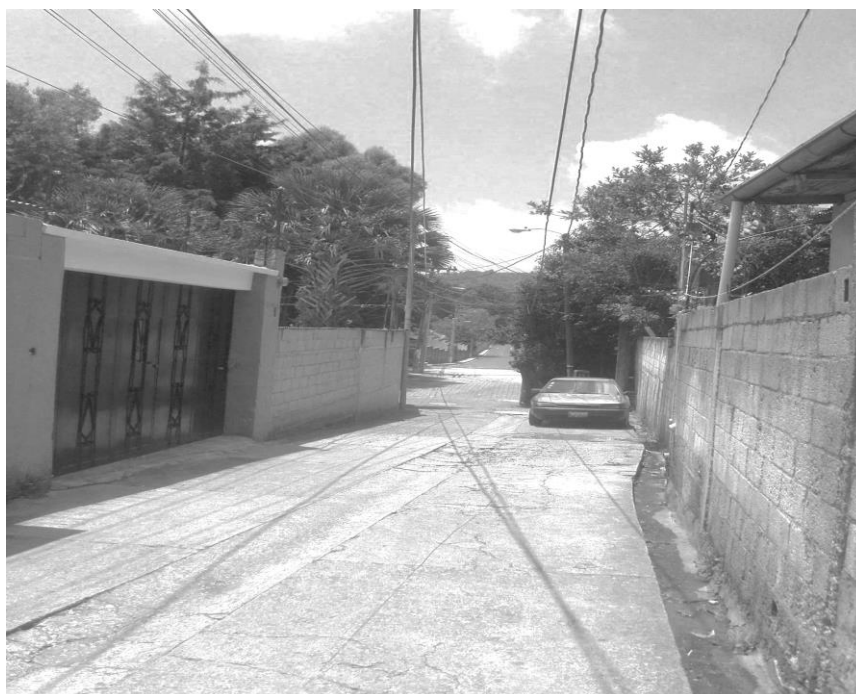
Figura 2. Calle de la aldea Puerta Parada
