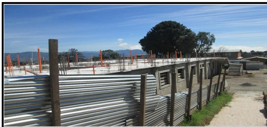
Figura 28. Reconstrucción del Centro de Salud
