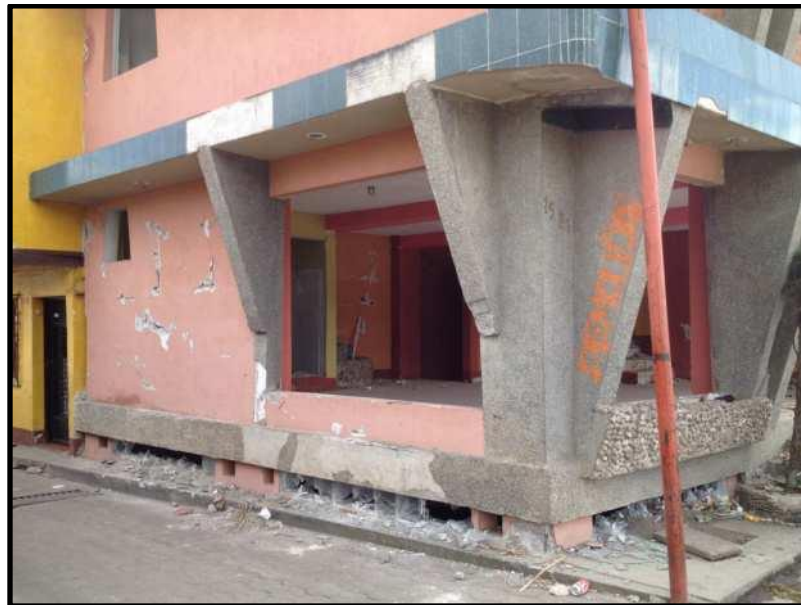
Figura 53. Estructura de esquina, híbrida
