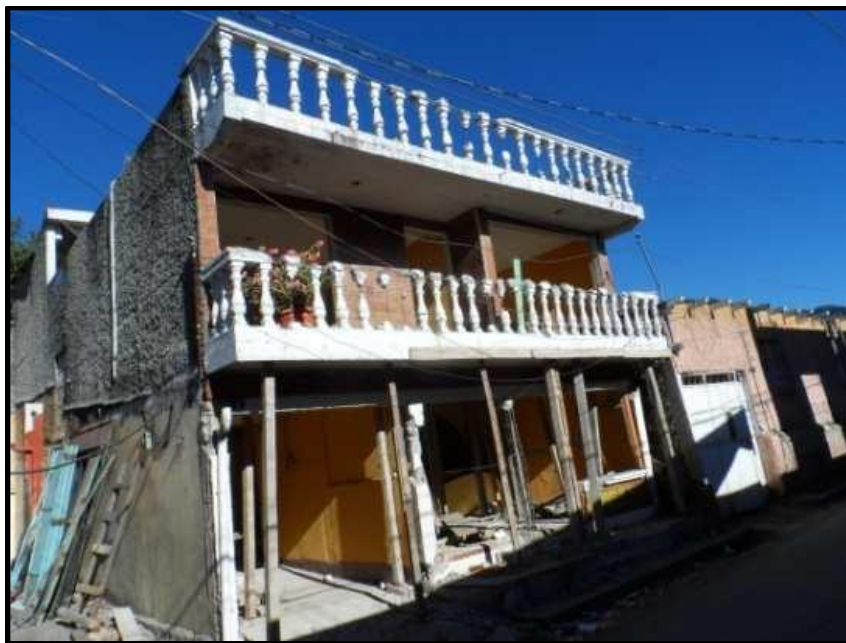
Figura 54. Estructura tipo túnel
