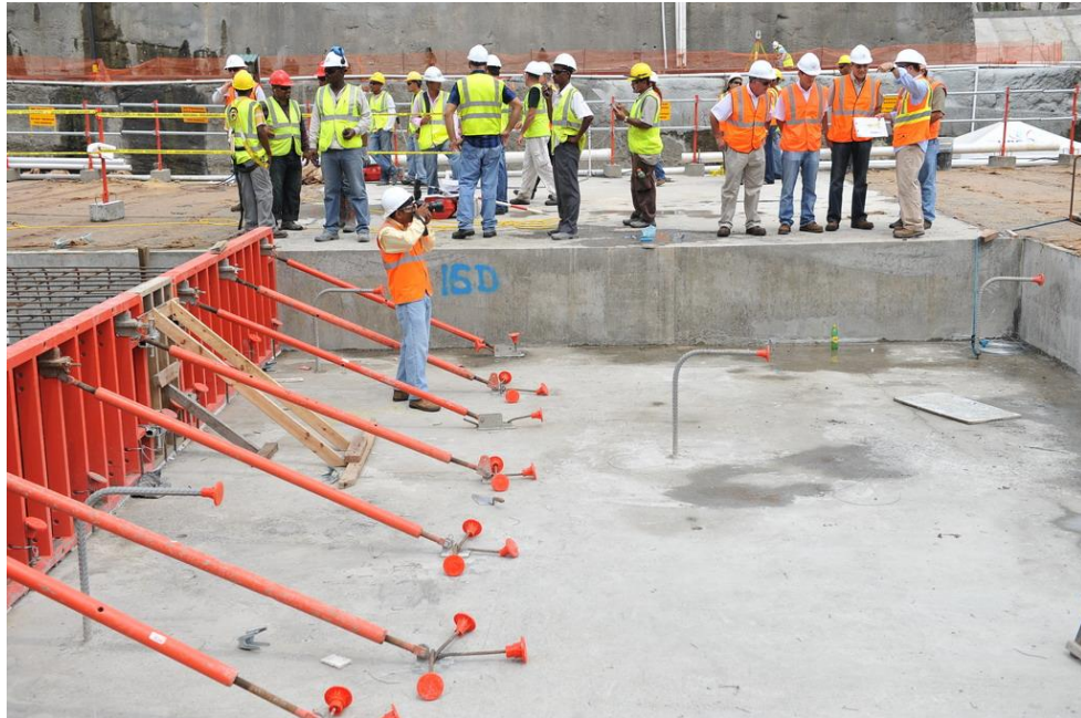
Figura 1. Trabajos de vaciado de concreto
