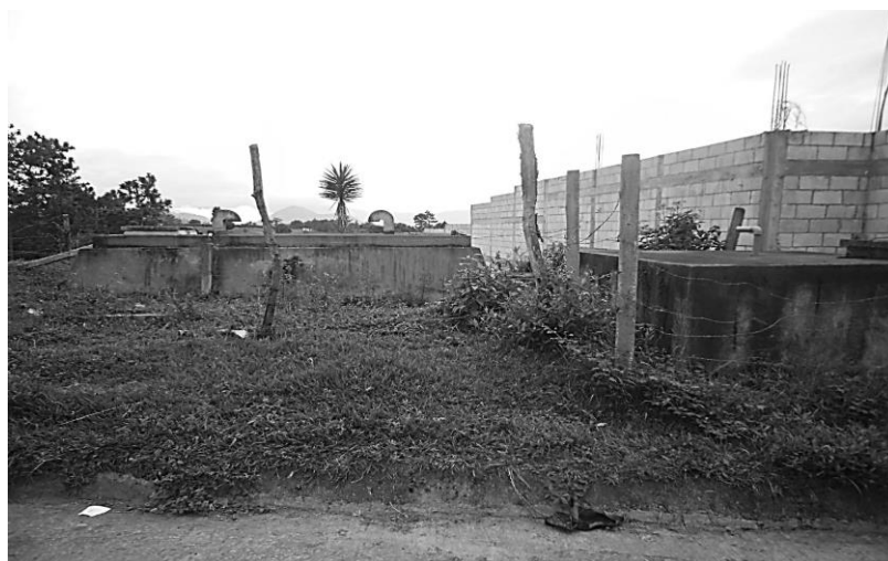
Figura 7. Tanques de almacenamiento 2
