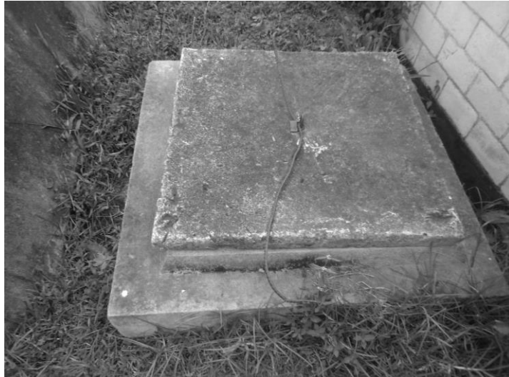
Figura 8. Depósito de cloración
