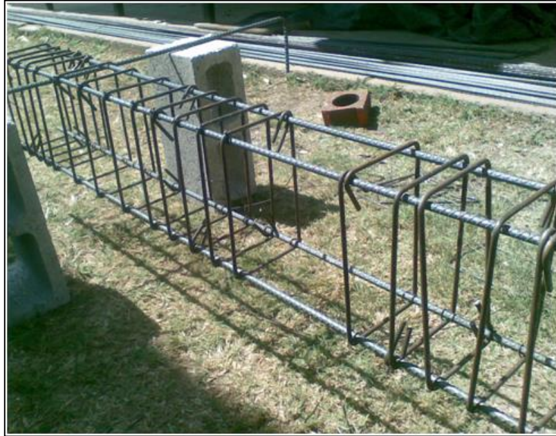
Figura 46. Amarre de estribos
