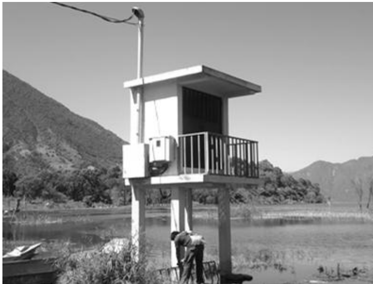
Figura 11. Caseta control de mando de bombeo
