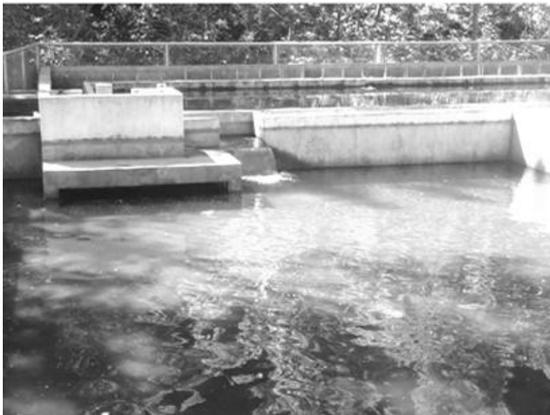
Figura 7. Filtro lento para potabilización
