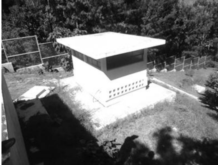
Figura 8. Caseta de cloración
