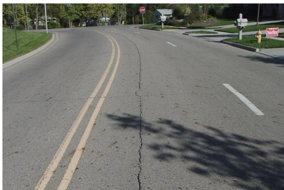
Figura 13. Grietas longitudinales
