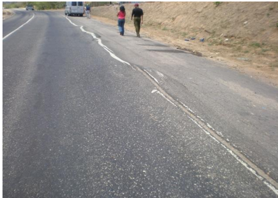
Figura 10. Desplazamiento de borde
