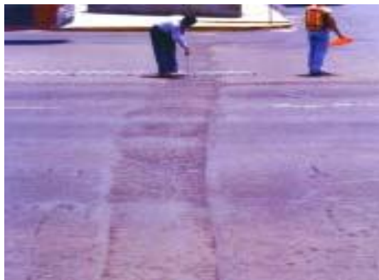
Figura 7. Asentamientos transversales
