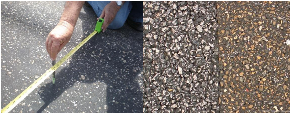
Figura 25. Desgaste de áridos
