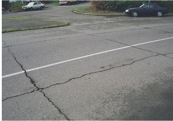
Figura 15. Reflexión de juntas
