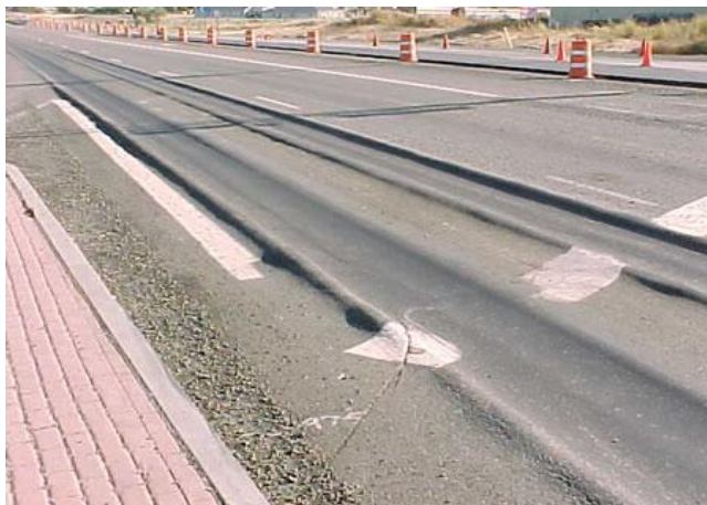
Figura 5. Huella de rodadura
