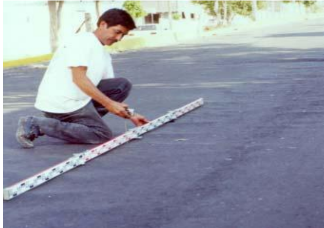
Figura 9. Abultamientos o corrugaciones
