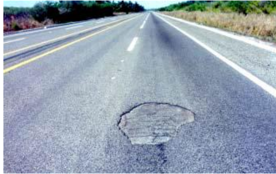
Figura 19. Peladura
