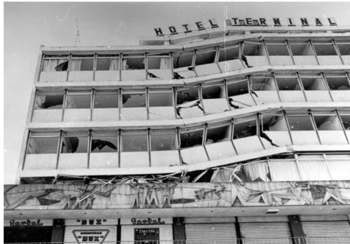
Figura 5. Vista del Hotel Terminal luego del terremoto de 1976
