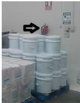
Figura 6. Ejemplo de extintor obstruido
