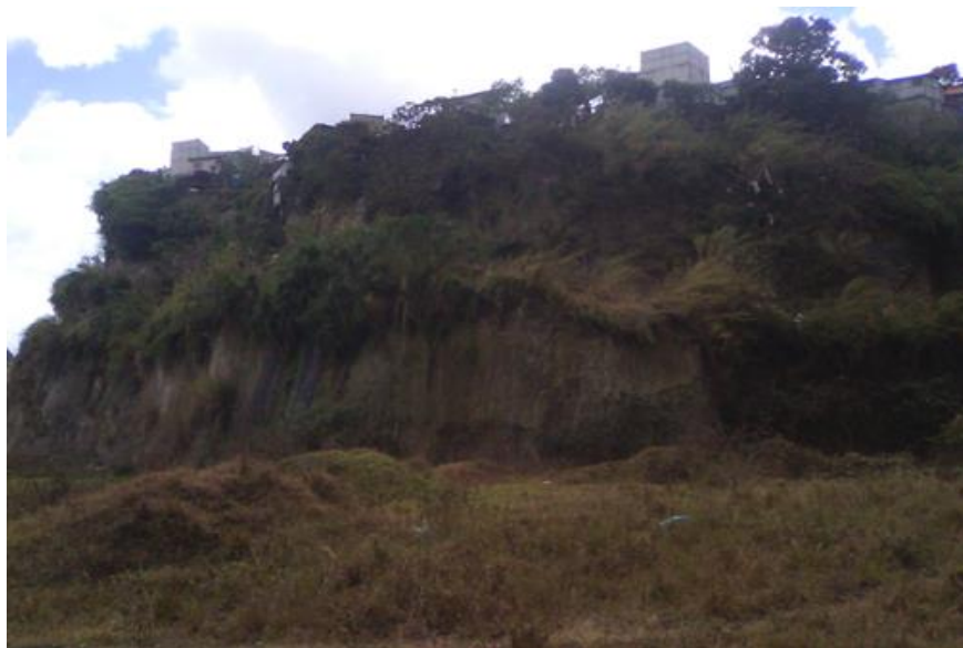
Figura 19. Talud vista elevación
