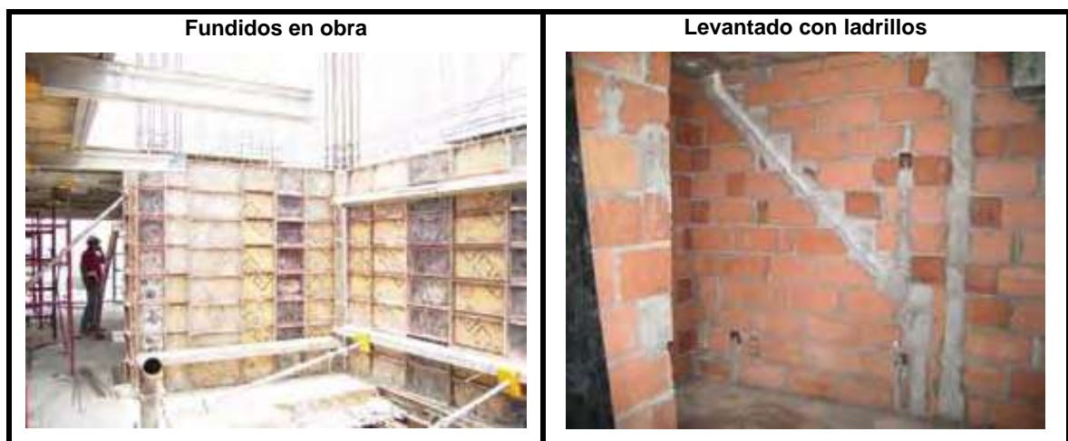
Figura 4. Diferentes sistemas de construcción de muros
