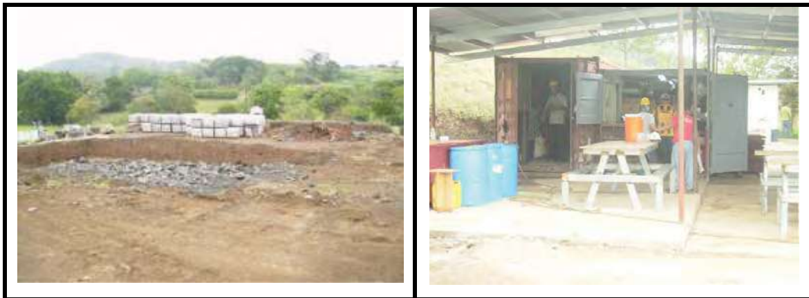
Figura 3. Actividades preliminares construcción de vivienda
