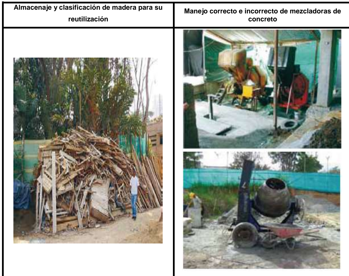
Figura 6. Manejo de materiales y equipo en obra
