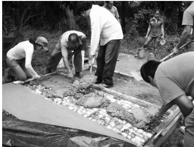
Figura 10. Fundición con mortero de segundo panel ecológico
