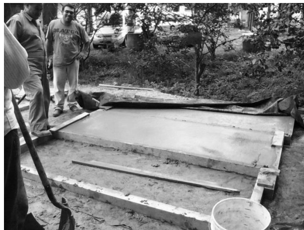
Figura 15. Finalización de la fundición
