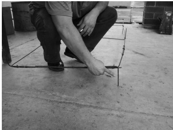
Figura 13. Detalle de pin acoplador para solera de corona
