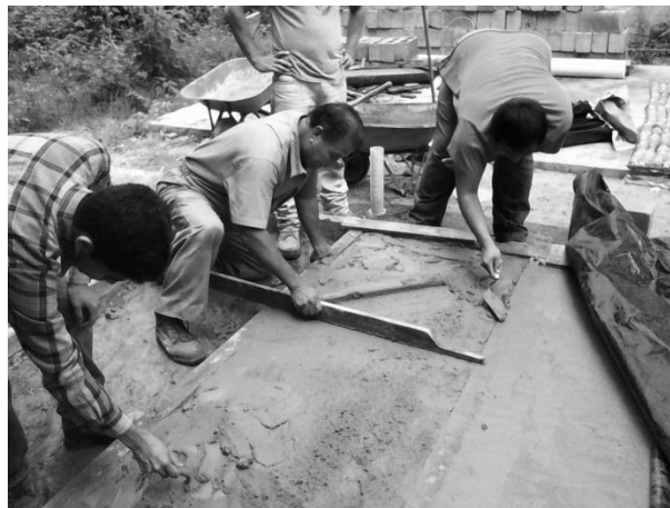
Figura 14. Vaciado del mortero y tendido del mismo
