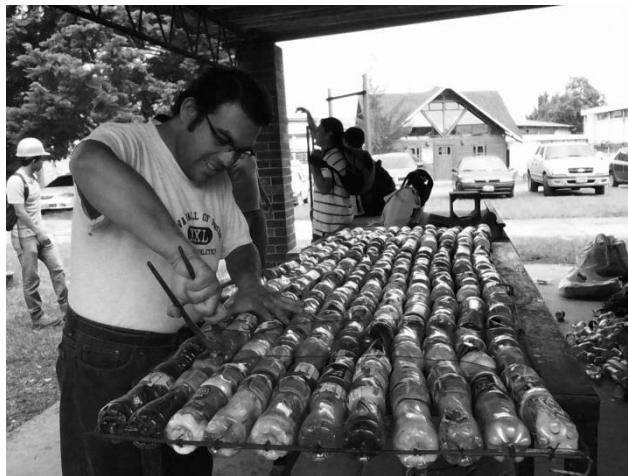
Figura 8. Ensamblaje de microcolumnas de botellas tipo PET
