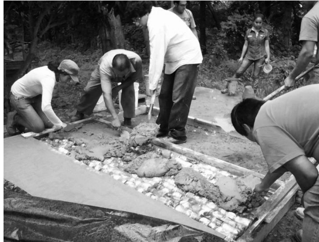
Figura 9. Fundición con mortero de panel ecológico
