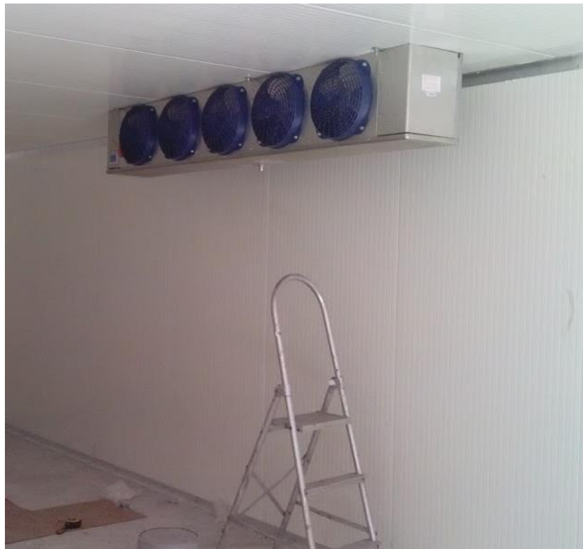
Figura 24. Instalación del evaporador
