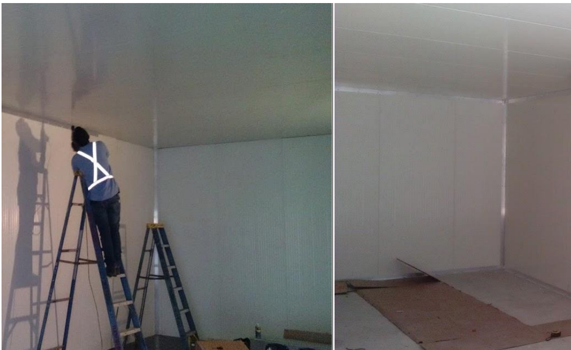
Figura 25. Instalación de angulares
