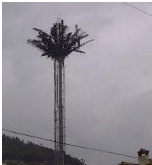
Figura 5. Mimetización de torres de telecomunicaciones
