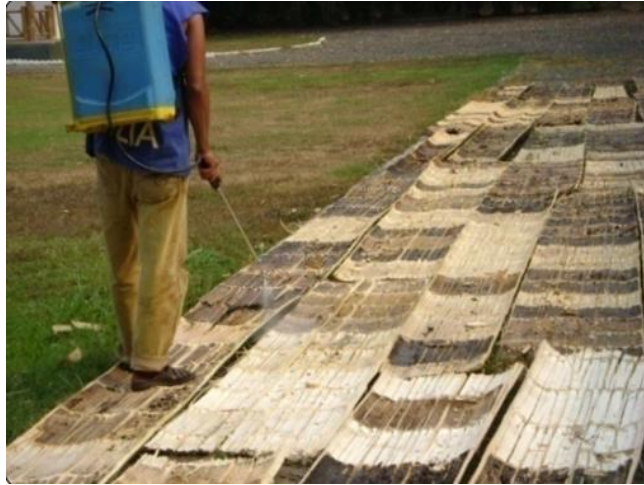
Figura 5. Tratamiento con diesel a esterilla (paredes y cielo falso de bambú)
