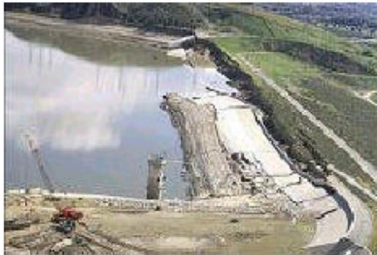
Figura 25. Deslizamiento en la presa Pacoima de San Fernando, terremoto de 1971
