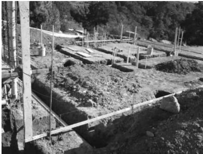
Figura 2. Trazo y zanjeo de casa
