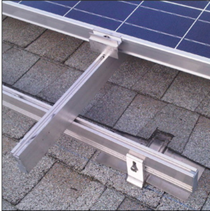
Figura 13. Anclaje de los paneles en la planta
