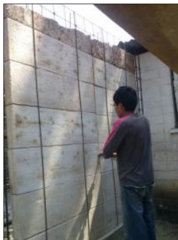
Figura 100. Colocación terminada de los núcleos
