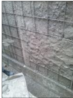
Figura 103. Lanzado del mortero
