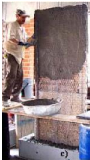
Figura 1. Construcción de muros tipo emparedado
