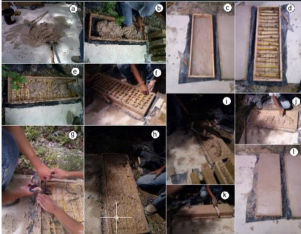
Figura 17. Construcción de núcleo CeNCa tipo “T”
