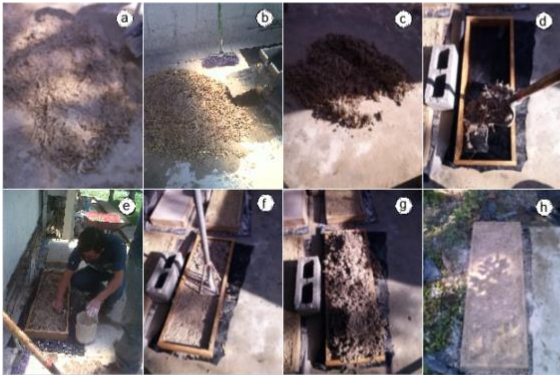
Figura 13. Construcción del núcleo CeNCa tipo “F”
