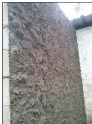
Figura 104. Colocación de la primera capa de mortero
