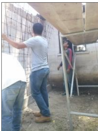
Figura 101. Colocación de la segunda malla electrosoldada
