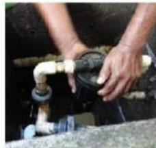
Fig. 6. Colocación del filtro.
