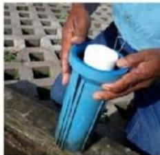
Fig. 5. Colocación del filtro dentro del case.
