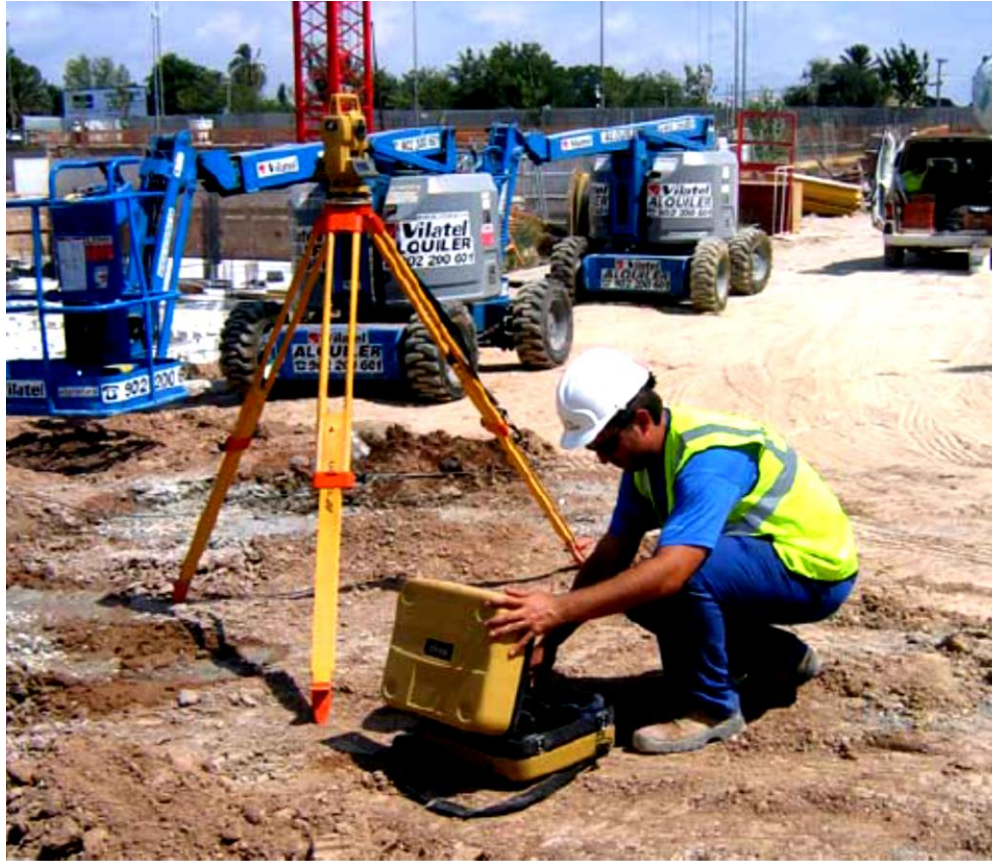
Figura 9. Trabajo de topografía en zanjeo
