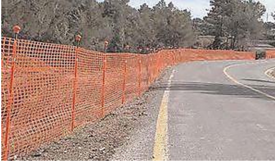
Figura 12. Señales de peligro
