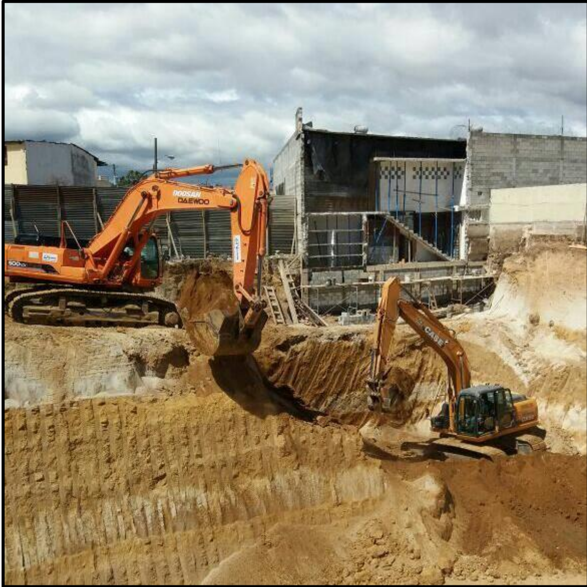
Figura 5. Excavación de sótano
