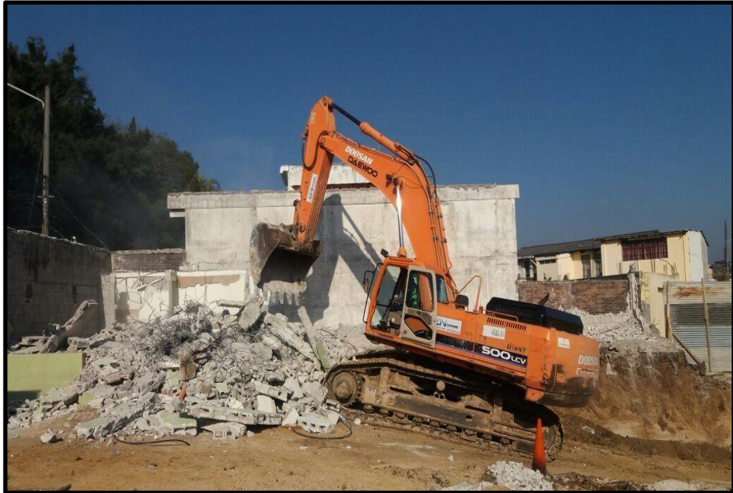
Figura 3. Demolición y excavación
