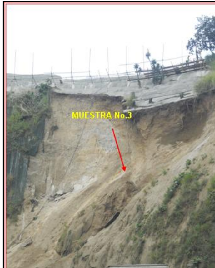
Figura 25. Ubicación de la muestra 3 en talud
