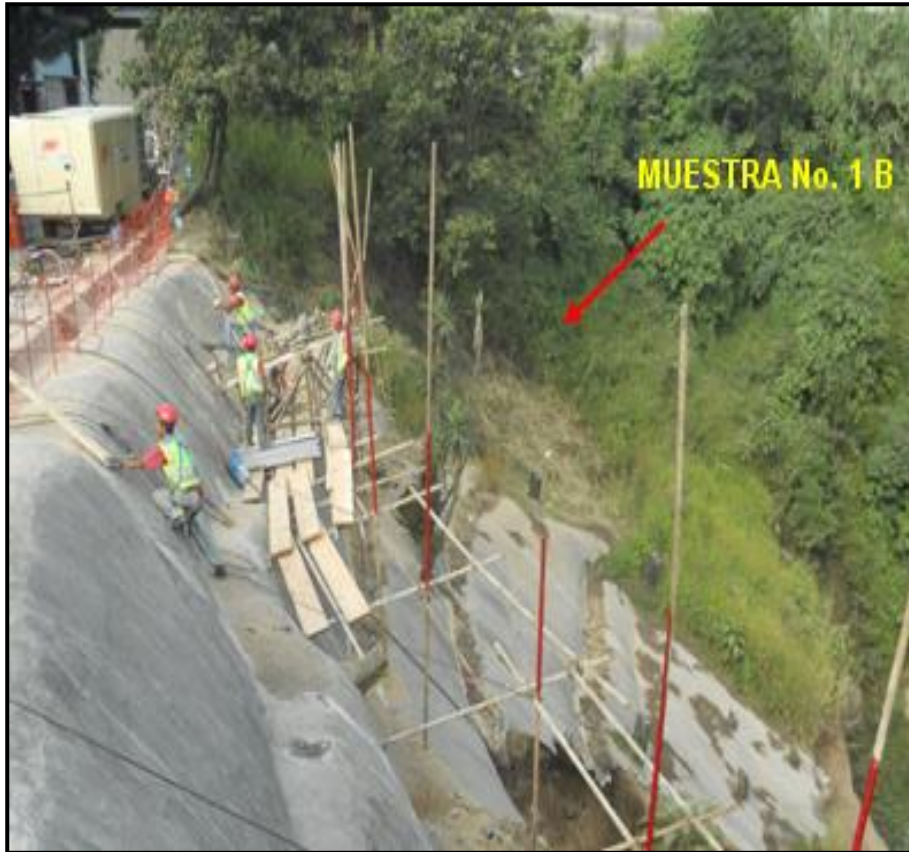
Figura 28. Ubicación de la muestra 4 en talud
