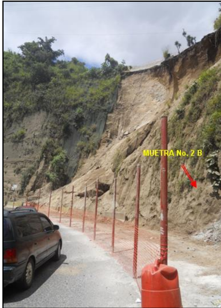
Figura 31. Ubicación de la muestra 5 en el talud
