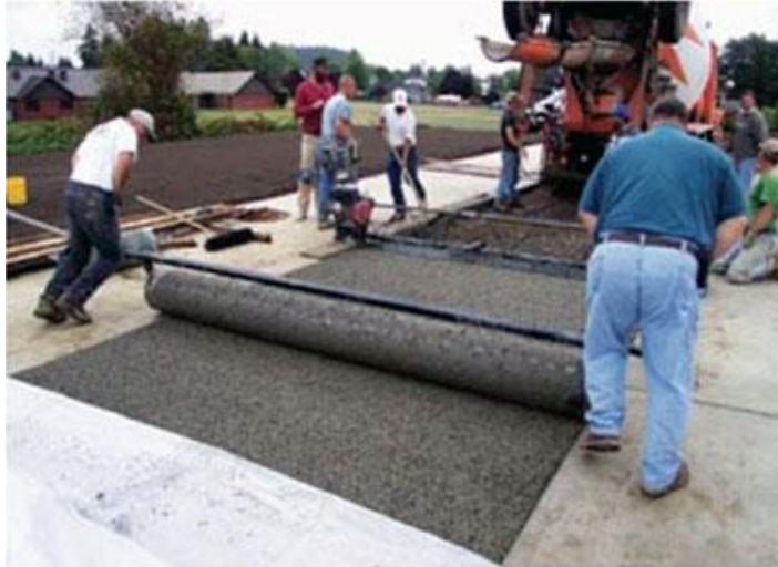
Figura 22. Compactado de pavimento de concreto permeable
