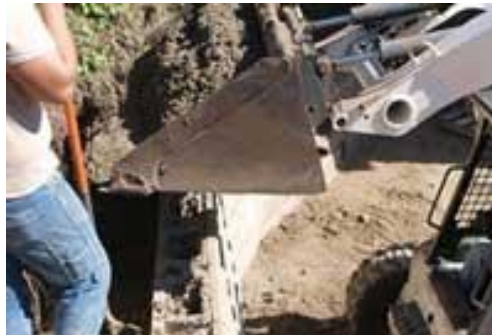
Figura 10. Relleno de muro de estabilización con concreto permeable según diseño de figura 9
