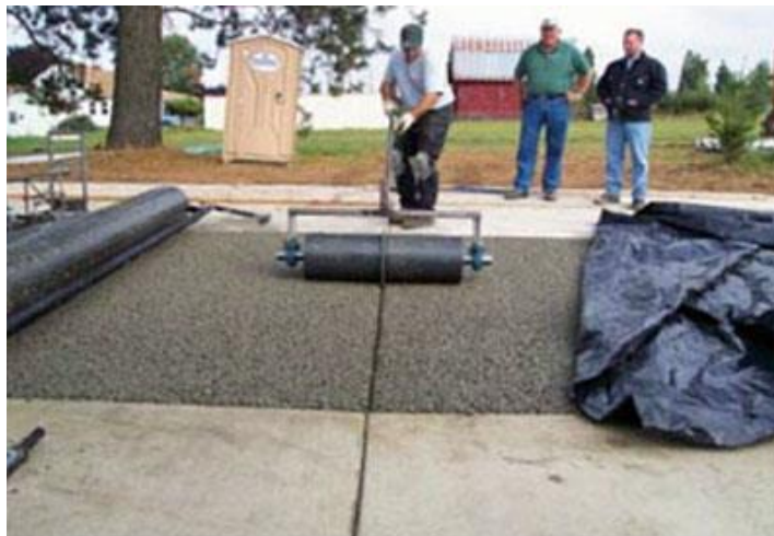
Figura 23. Cortado de pavimento de concreto permeable.
