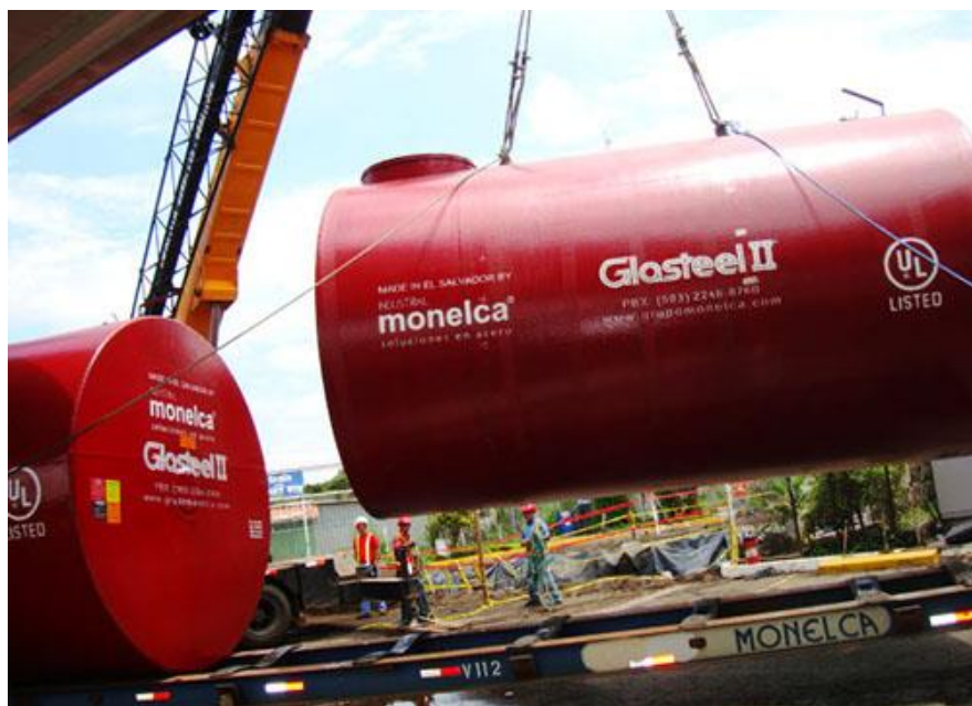
Figura 24. Tanques de doble pared
