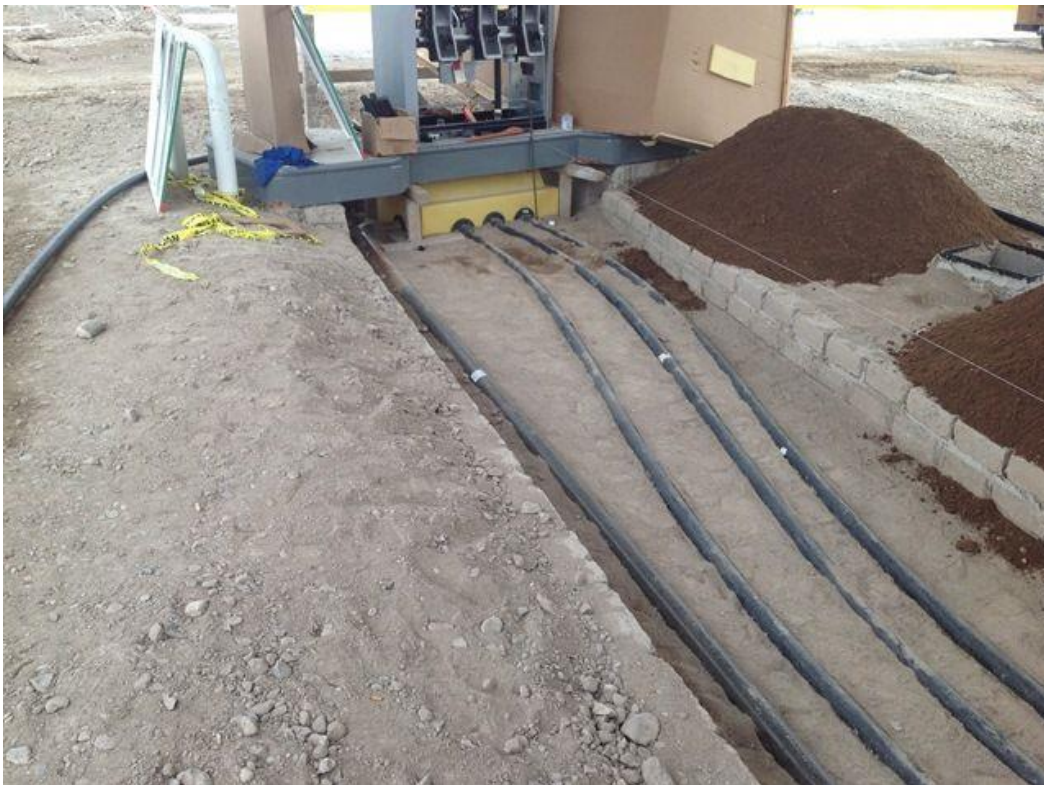
Figura 29. Tubería flexible instalada
