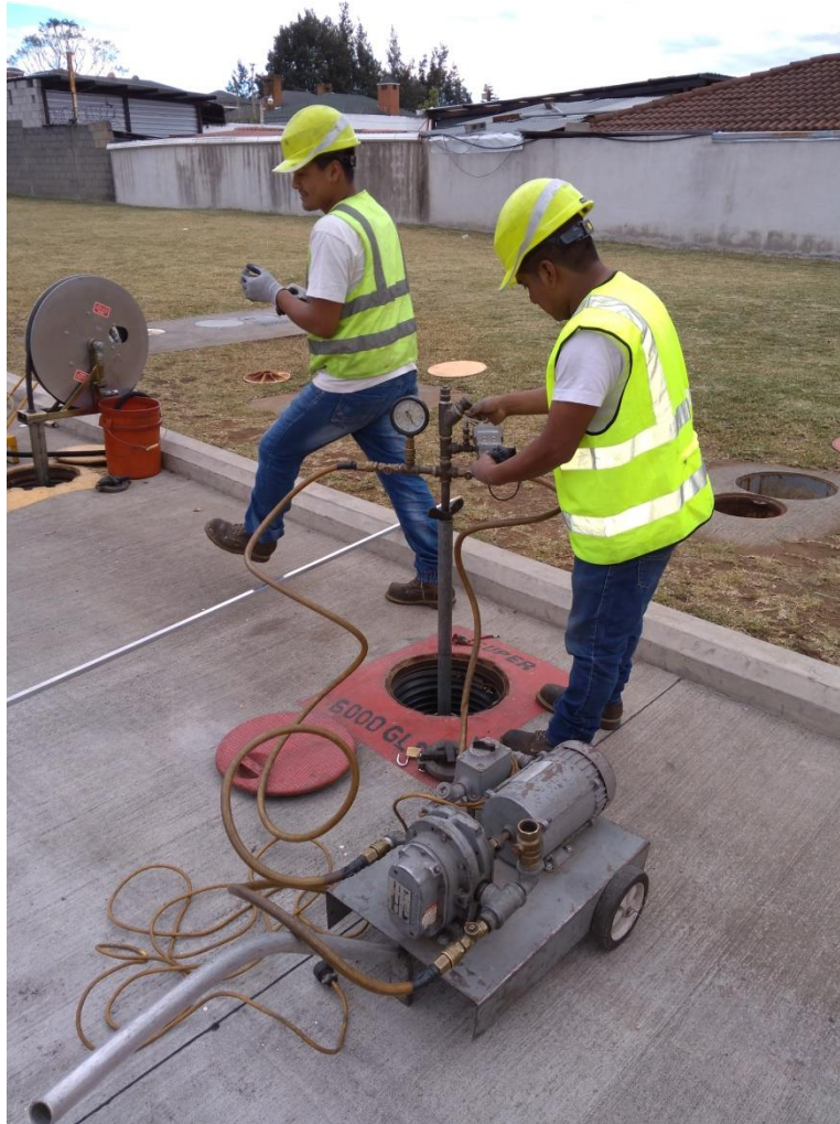
Figura 34. Prueba de funcionalidad en tanques
