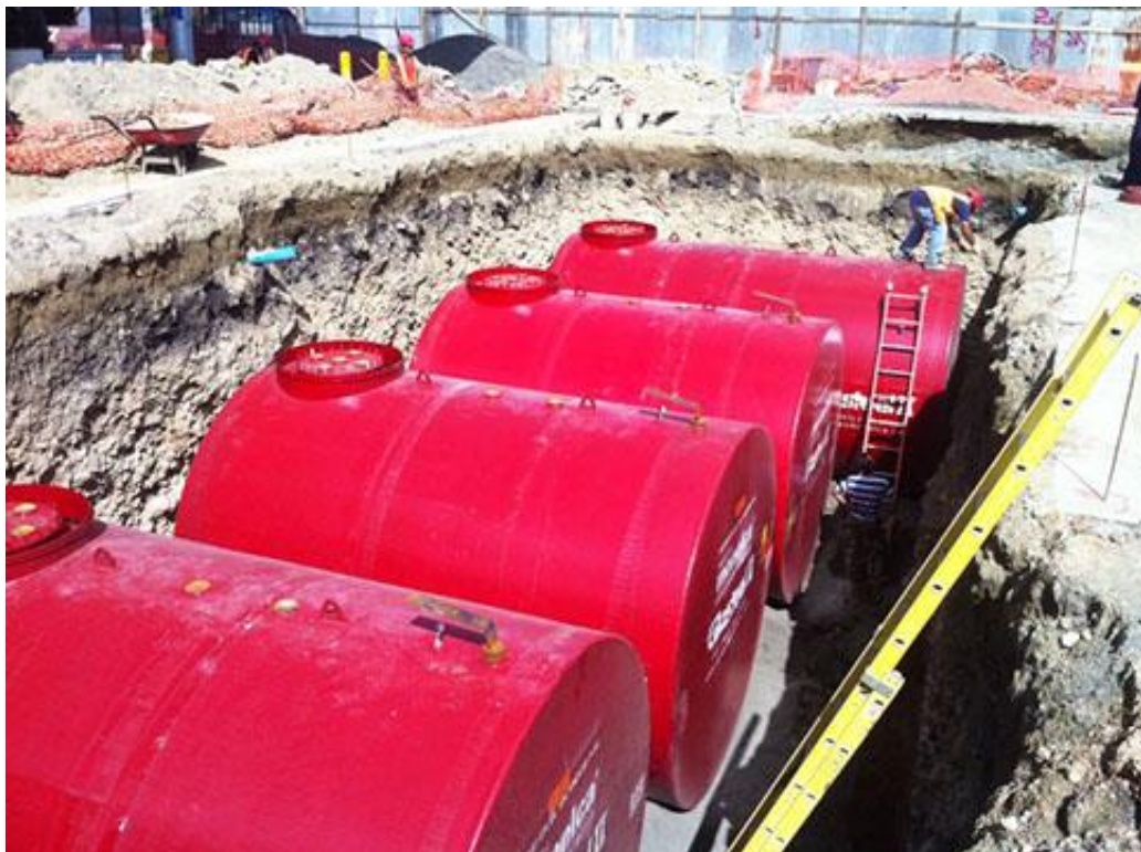
Figura 25. Instalación de tanques de doble pared
