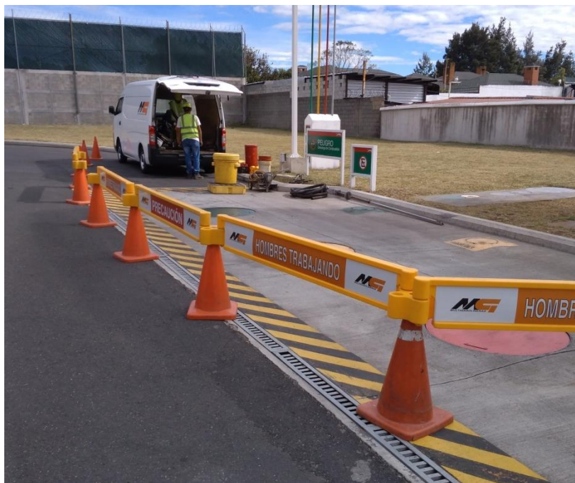
Figura 15. Inspección de condiciones en gasolinera CODO
