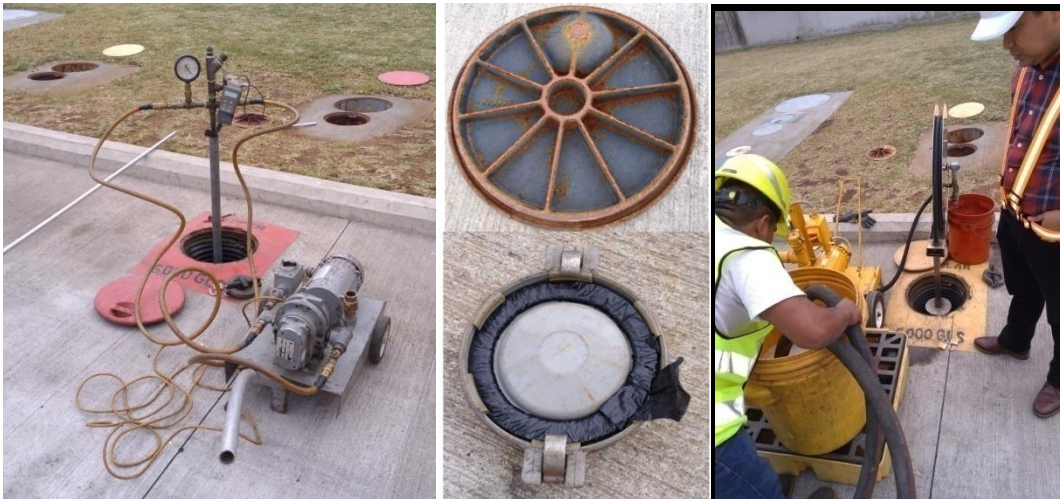
Figura 17. Tanques y tuberías de gasolinera CODO
