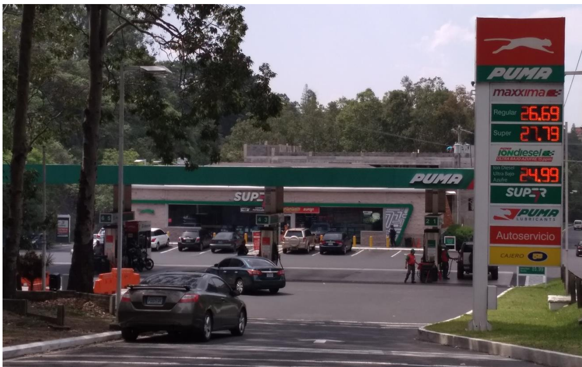
Figura 8. Instalaciones gasolinera agencia
