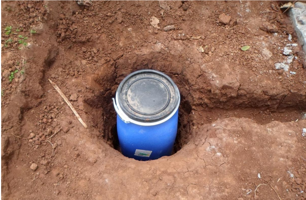
Figura 13. Detalle del tanque de almacenamiento para reutilización de agua tratada
