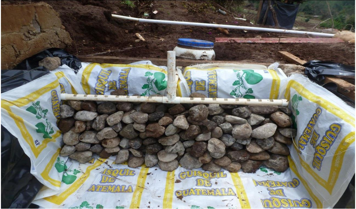
Fotografía 3. Colocación del material filtrante
