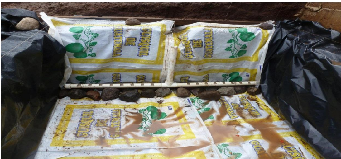
Fotografía 2. Impermeabilización de la biojardinera
