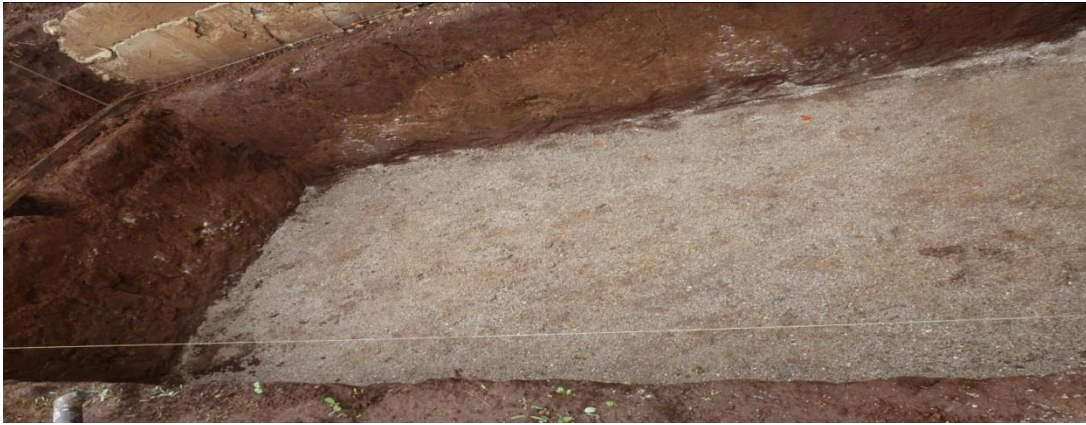
Fotografía 1. Nivelación del terreno
